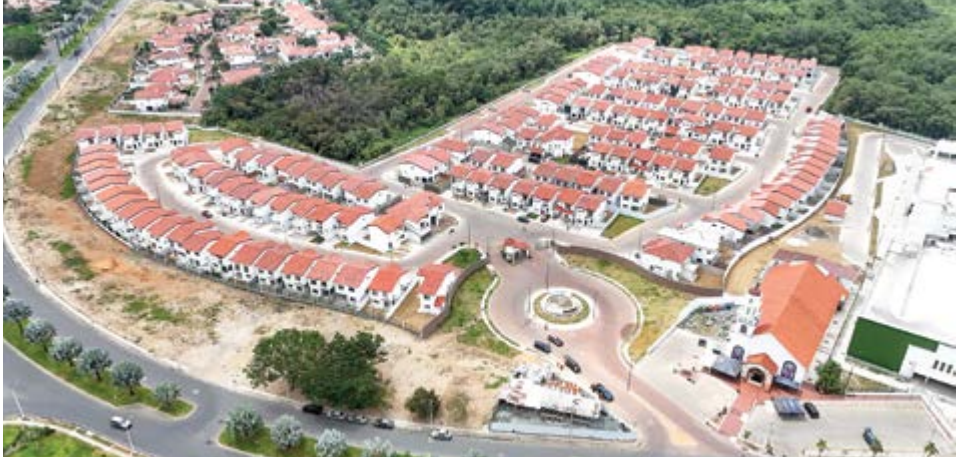
>> La urbanización Terranostra es uno de los proyectos entregados por la constructora.
