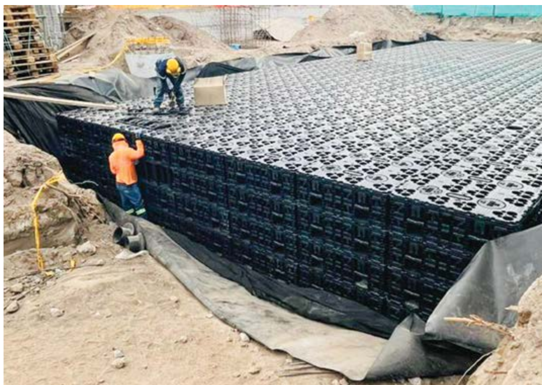
» AquaCell 400, es un sistema modular fabricado en polipropileno de alta resistencia y 100% reciclado, que reemplaza estructuras pesadas (como tanques convencionales).
